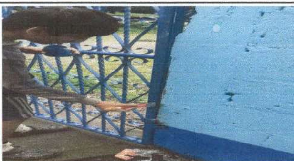
FOTO 3: SUSTITUCIÓN DE PORTÓN DE METAL
