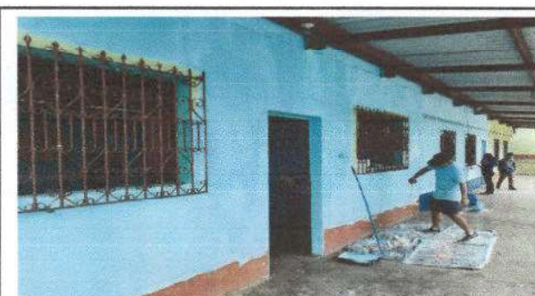
FOTO 6: SUSTITUCIÓN DE VENTANAS DE MADERA POR METAL MÁS VIDRIO Y PINTURA EN MUROS EXTERIORES E INTERIORES
