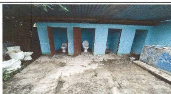
FOTO 5: SUSTITUCIÓN DE INODOROS
