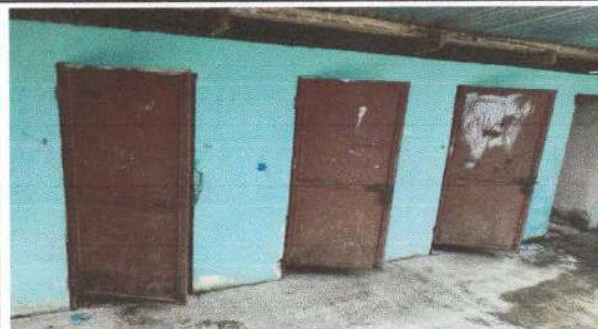
FOTO 2: SUSTITUCIÓN DE PUERTAS DE SERVICIO SANITARIOS
